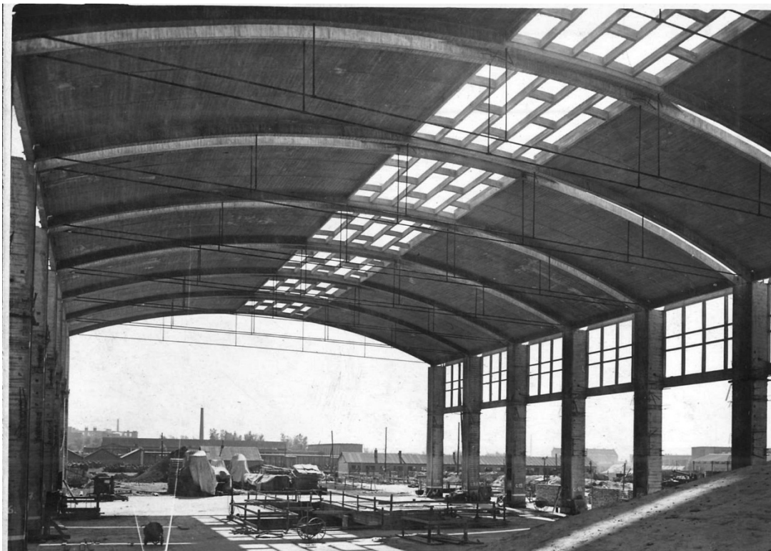
15.kép: Kábelgyár, a főhajó. Figyeljük meg, hogy a pillérek közé itt is vasbeton ablakkeretek kerültek No. 5466
