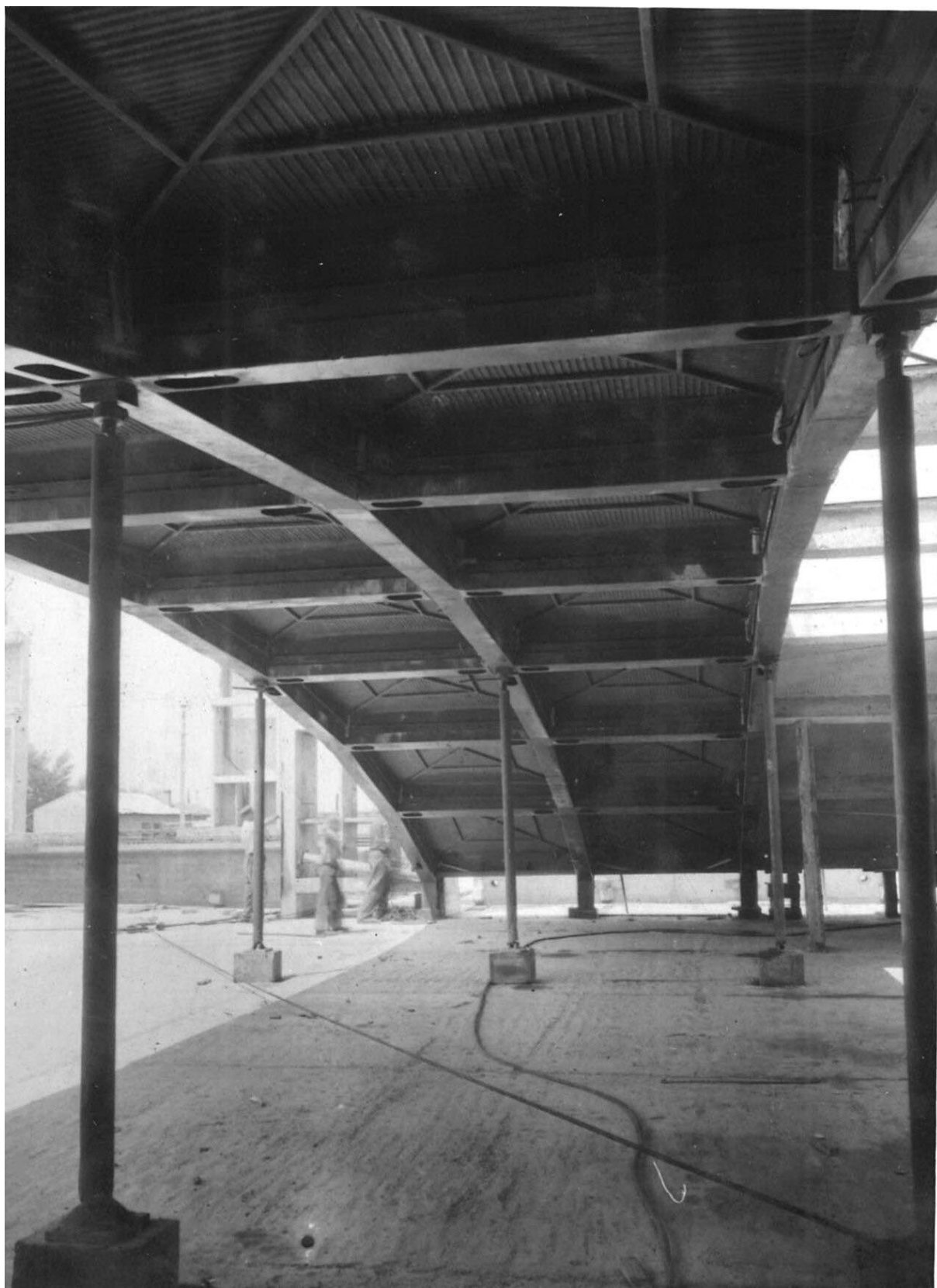
7.kép: IKARUS, a donga zsaluzatának váza alulnézetben, a rájuk helyezett zsálmezőkkel No. 3885
