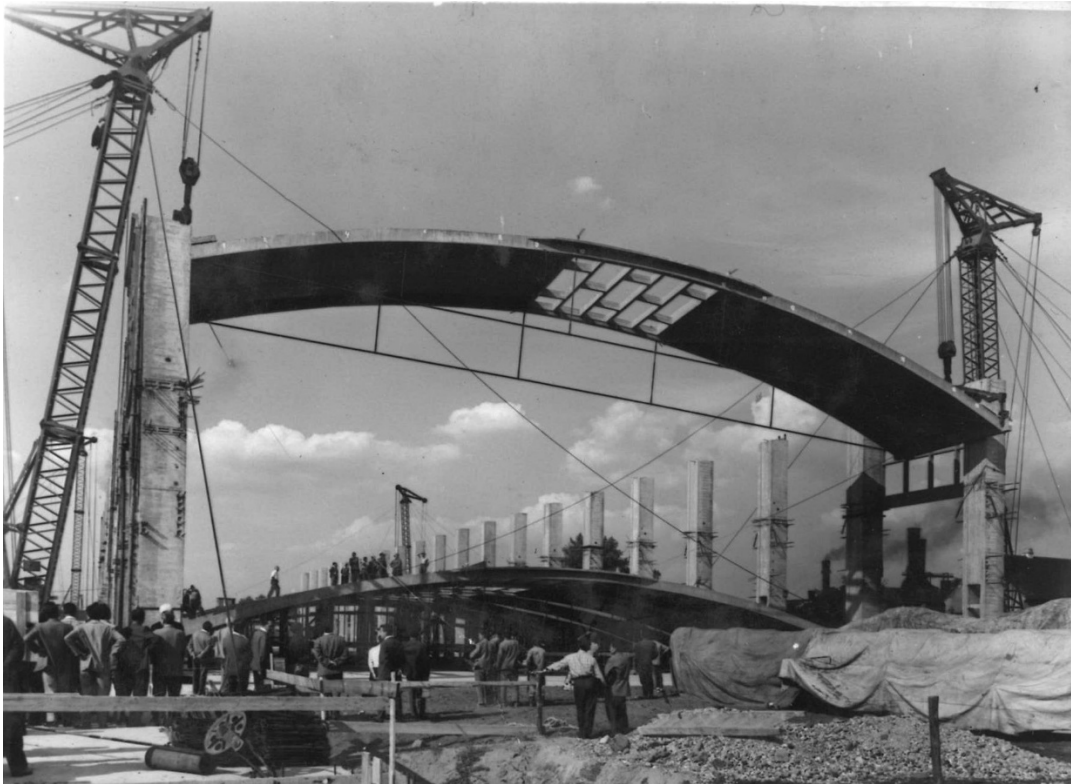
14.kép: Kábelgyár, az első donga emelése No. 5463
