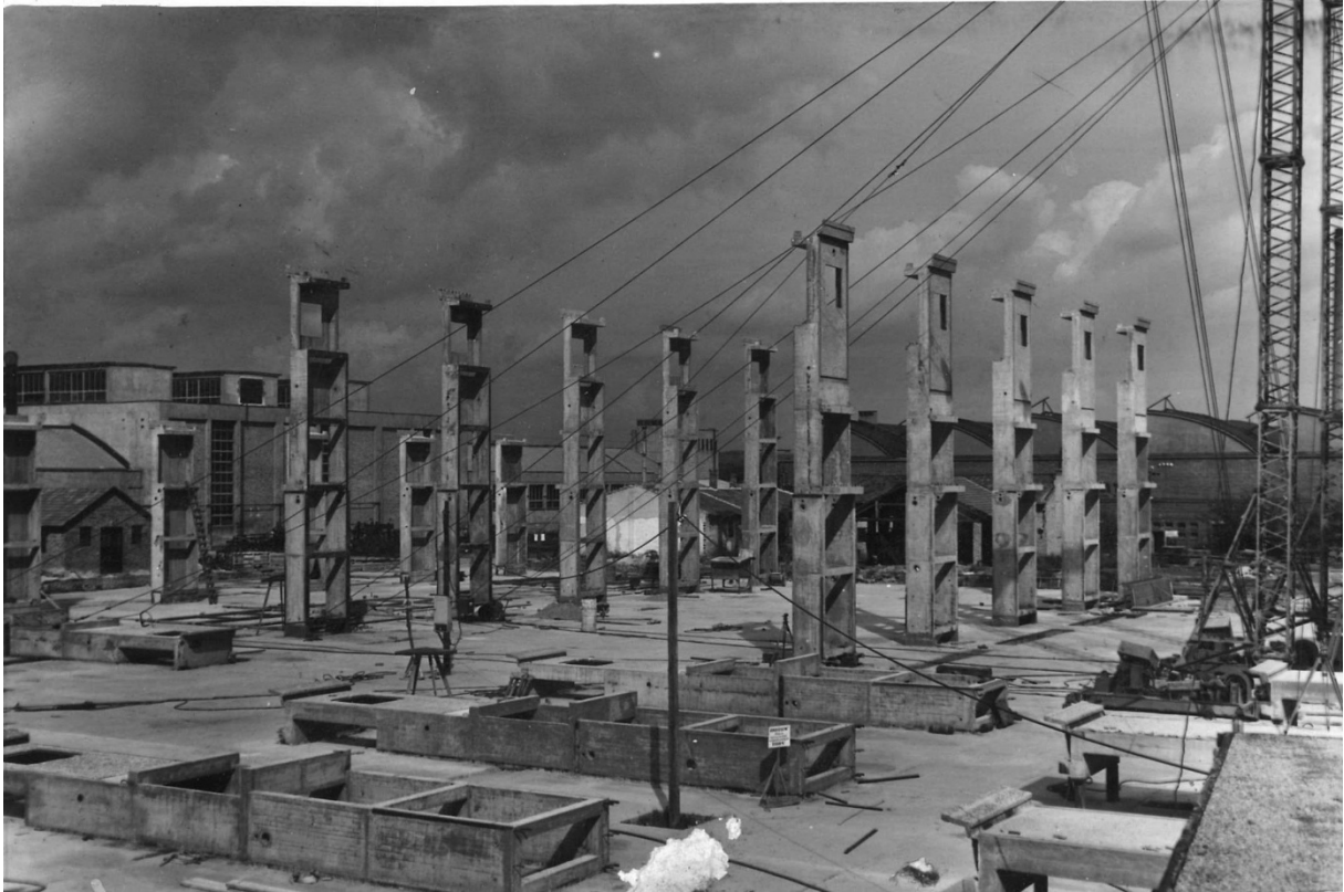
1.kép: IKARUS építkezés, a kazettás falpillérek gyártása és felállítása No. 3190
