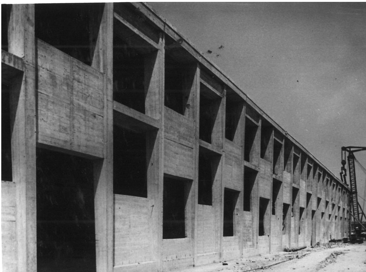
17.kép: Kábelgyár, amíg a főhajó mentén, a mellékhajók irányába történő szabad átjárás biztosítása érdekében kis alaprajzi kiterjedésű (tömör) pillérek állnak, addig az oldalhajók homlokzatait kazettás beton falpillérek képzik No. 5828
