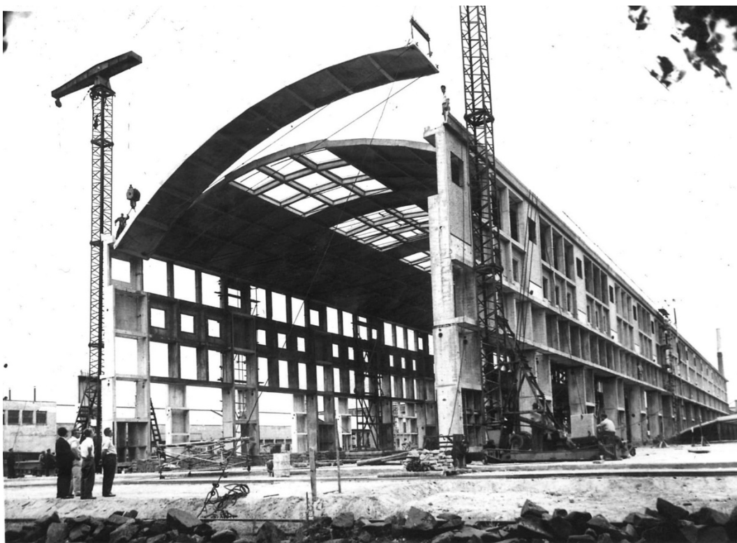
8.kép: IKARUS, a dongaelemek emelése, az elem stabilitásához a vonórudakra is szükség van No. 3899
