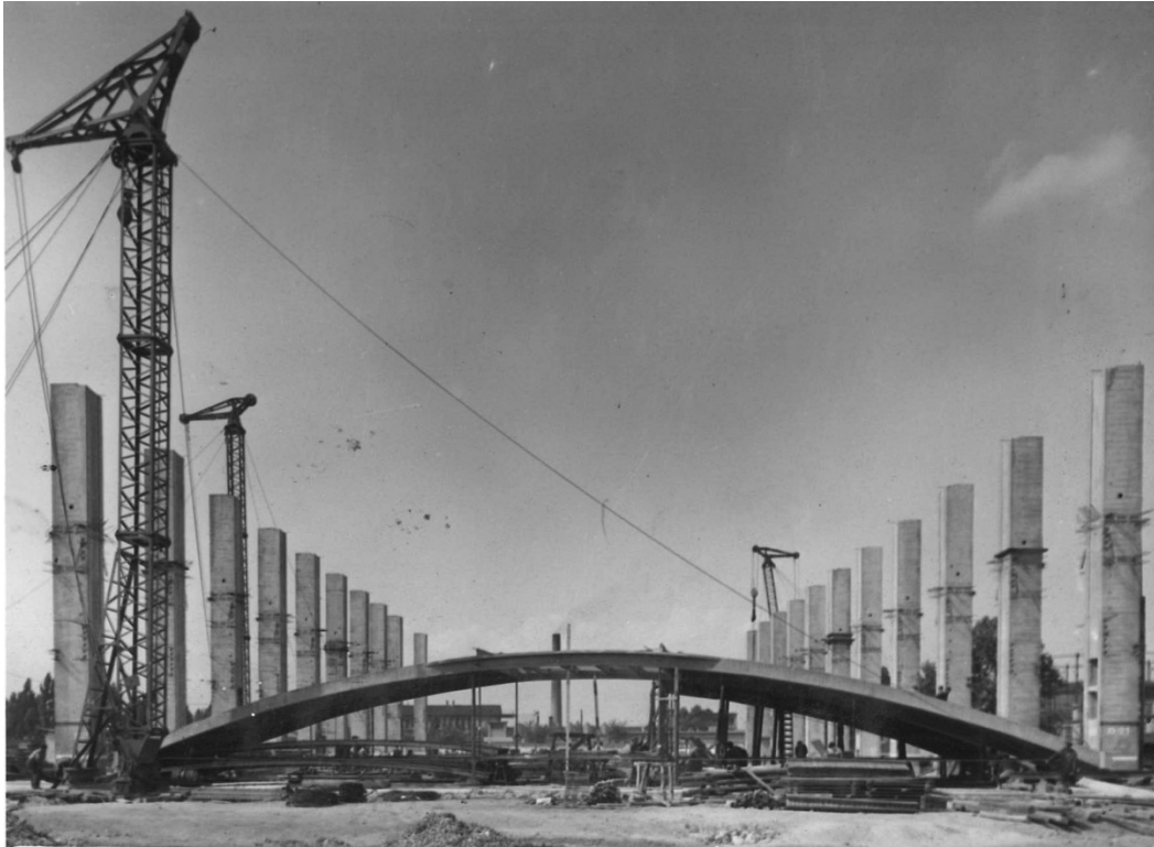
12.kép: Kábelgyár építkezés, egyszerűbb pillérek, nagyobb fesztávolságú domba (32,00 m) No.5013
