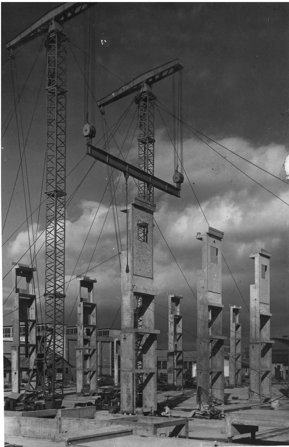
2.kép: IKARUS, a kazettás falpillérek felállítása No. 3193
